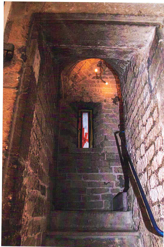
Die Eigelsteintorburg von innen, im Moment eingehüllt in ein Baugerüst.
